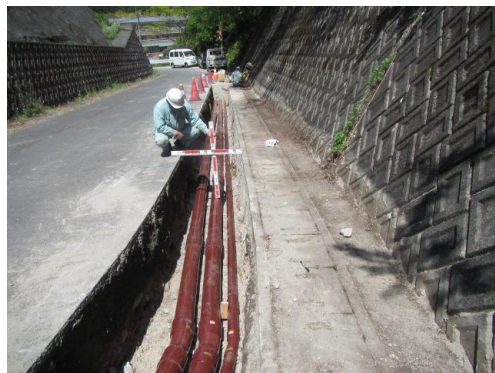
温泉供給に向けた埋設配管工事
