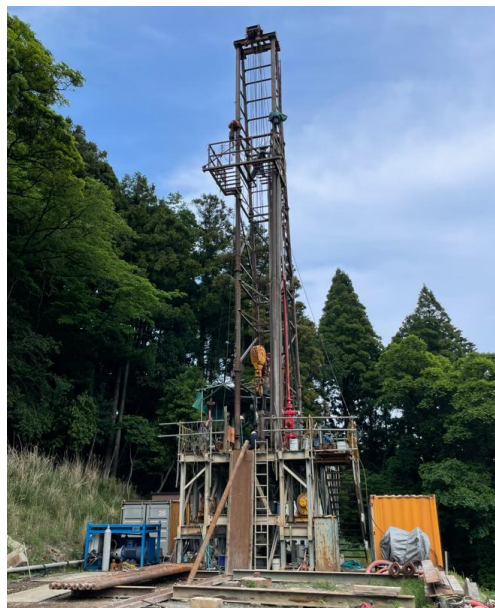
温泉掘削リグの設置状況
