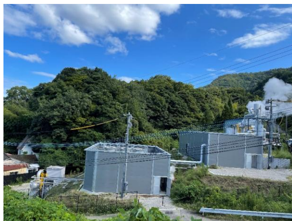
完成した2つの地熱バイナリー発電所（防音壁を設置）
