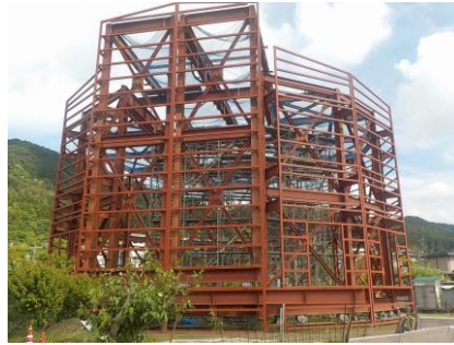
日本でのエンクロージャー鉄骨試験組み立て
