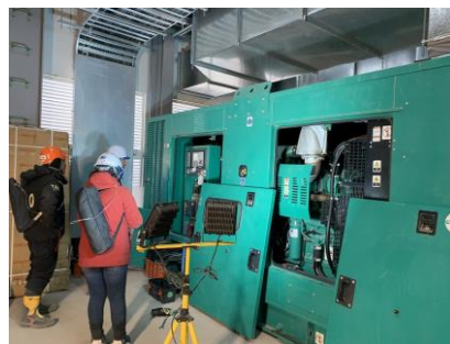
大型発電機システム設置
