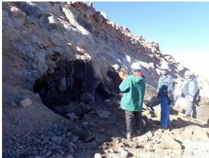
道路工事ダイナマイト作業
