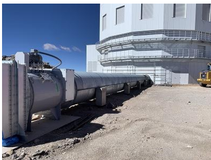
エンクロージャー棟施設から 長い排気ダクトによる 大型排気設備設置
