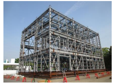
日本での観測運用棟鉄骨試験組み立て
