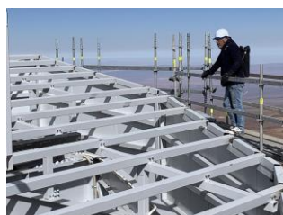
エンクロージャー棟屋根作業
