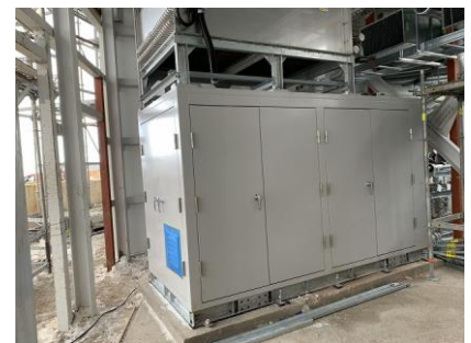
冷却水設備設置
