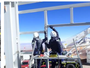
山頂で酸素ポンペを背負いながら工事を行う作業員
