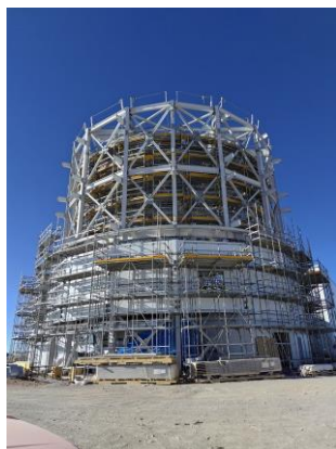
エンクロージャー鉄骨工事時
